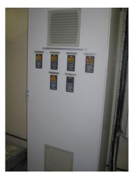
У преобразователей частоты «Данфосс» существует возможность выноса панелей оператора на дверь шкафа управления для обеспечения удобного доступа персонала. Стоит отметить, что панель оператора преобразователей частоты «Данфосс» удобна и проста в работе. Для заказчика было очень важным фактором наличие качественного сервисного обслуживания в Москве приводной техники «Данфосс», которое осуществляет компания «Миг Электро», официальный сервисный партнер.
