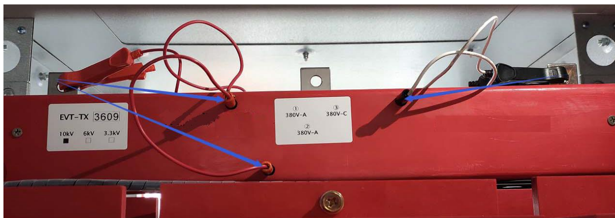
Рис. А.2 – Подключение перемычек для низковольтного тестирования УПП на электронном потенциальном трансформаторе
