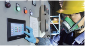
Очистка отработанных газов
