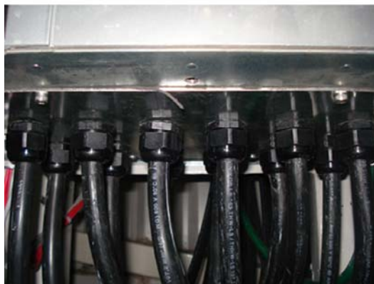
Рисунок 3.32: Пример правильной установки платы уплотнений.
