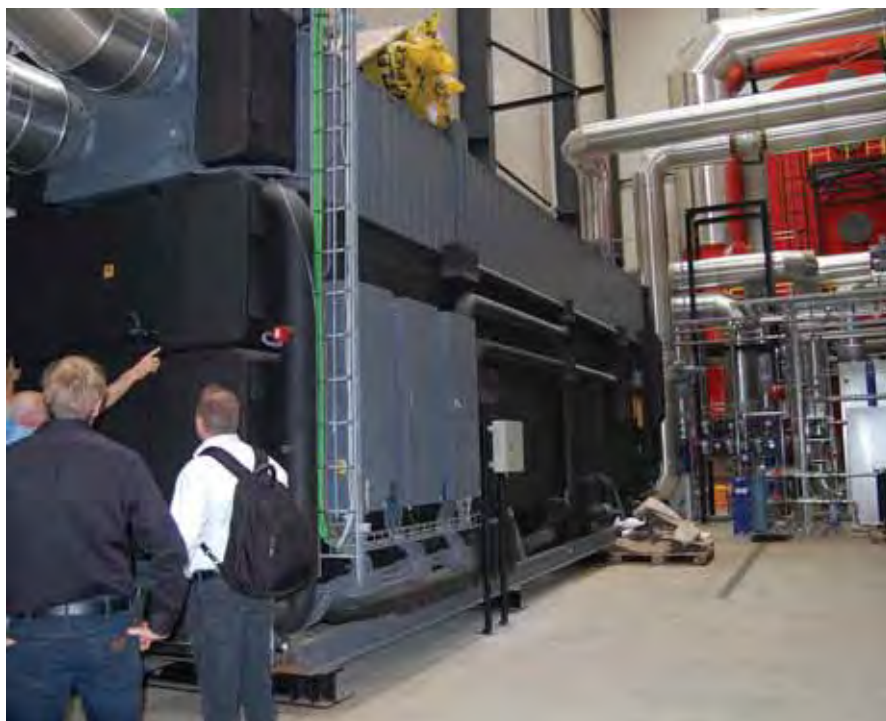
На переднем плане абсорбер. На заднем - скрубберы.
