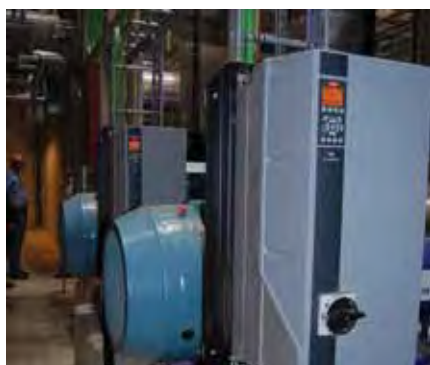
Двигатели SynRM IE4 укомплектованы преобразователями частоты серии VLT Automation Drive FC 302.
