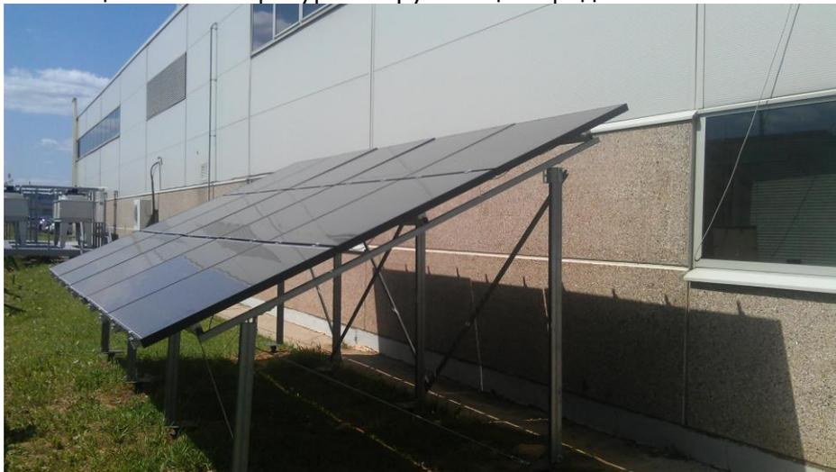
Солнечные модули установлены на земле под углом на опорных конструкциях из алюминиевой антикоррозионного профиля и сориентированы на юг. Инвертор находится рядом со станцией в компрессорной. Сама станция располагается рядом со зданием Энергоцентра «Данфосс».
