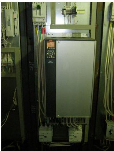
На основе полученных данных была разработана проектная документация. Было решено произвести замену коммутационного оборудования распределительной подстанции котельной за счет установки преобразователей частоты на сетевые, питательные насосы и приводы решеток котлоагрегата, для улучшения работы агрегатов, экономии электроэнергии.
