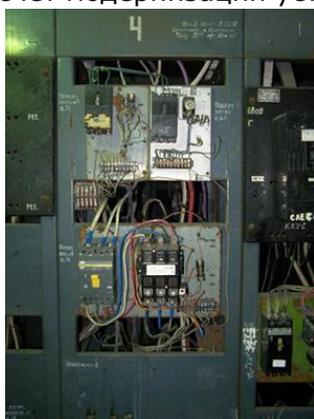
Рис.2 Панель управления до модернизации
