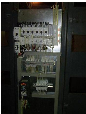
Для экономии угля на двигатели решеток были установлены преобразователи частоты серии Micro Drive, что позволило регулировать скорость решетки для более качественного сгорания угля и решению вышеуказанной проблемы. В процессе модернизации котельной компанией «ТЭТ-РС» были установлены новые силовые панели с коммутационным оборудованием и преобразователями частоты
