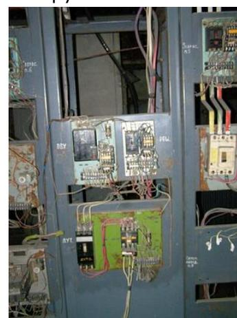
Рис.3 Панель управления решеткой и ВВУ до модернизации
