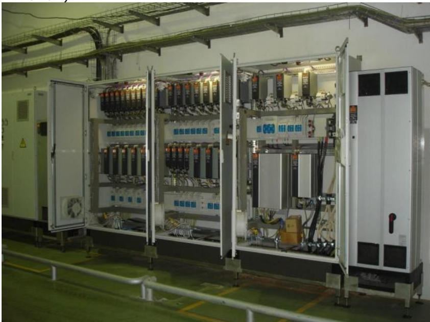
Цель применения преобразователей частоты в данном проекте – обеспечение гибкости и точности выполнения технологического процесса – дозированной подачи ингредиентов и готового продукта, необходимой степени перемешивания в емкостях. От работы приводов насосов и мешалок зависели структура, внешний вид и вкусовые качества кетчупа, в итоге его популярность среди покупателей.
