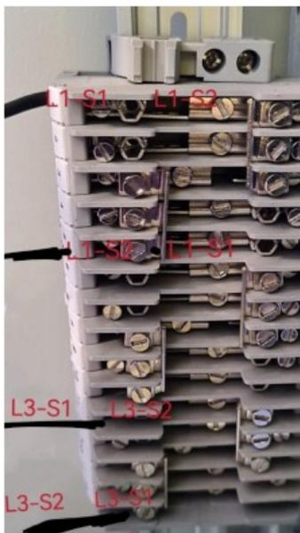
*Рисунок 8-36 - Подключение внешнего кабеля ТТ*
