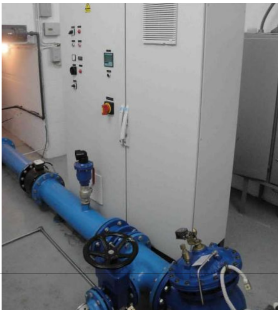
Установка с устройством плавного пуска VLT ® MCD500
