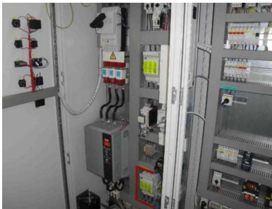
Установка с устройством плавного пуска VLT ® MCD500
