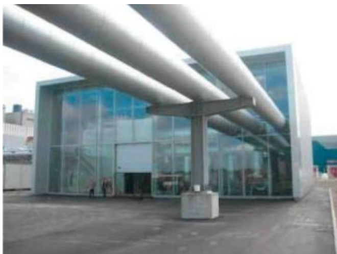
Новое здание насосной станции на тепловой электростанции Амагер
