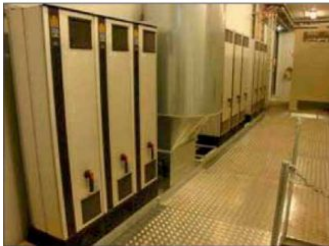
Привод VLT® AQUA FC202 6x355 кВт и 3x160 кВт
