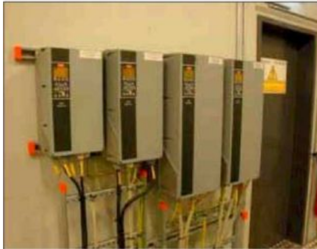
Настенный привод VLT® AQUA FC202 в корпусе со степенью защиты IP55
