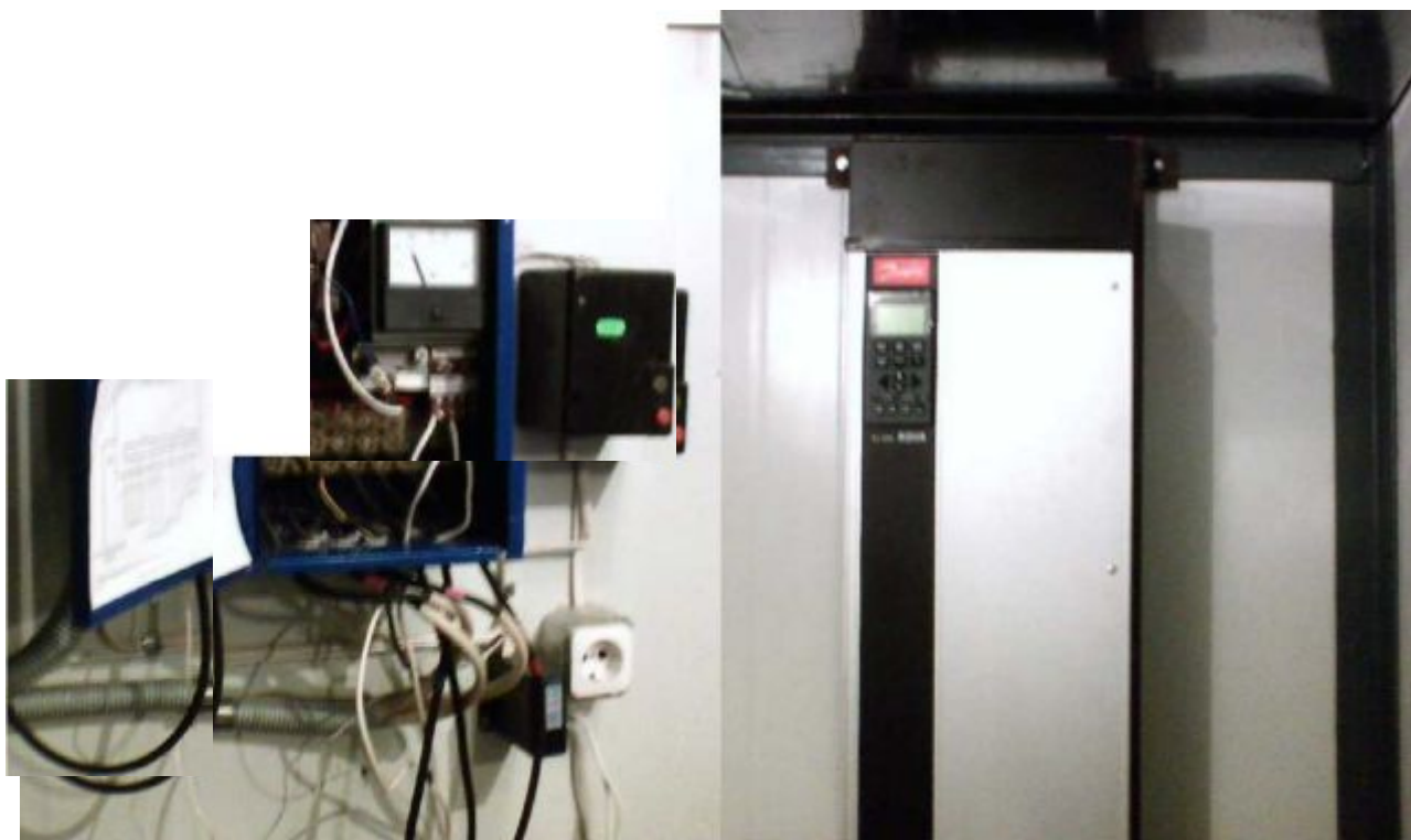
Рисунок 2 Система управления до установки VLT8022 Aqua (а), преобразователь частоты VLT8022 Aqua (б).
