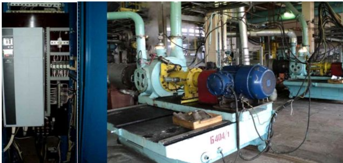
Рис.3 Фото оборудования после модернизации
