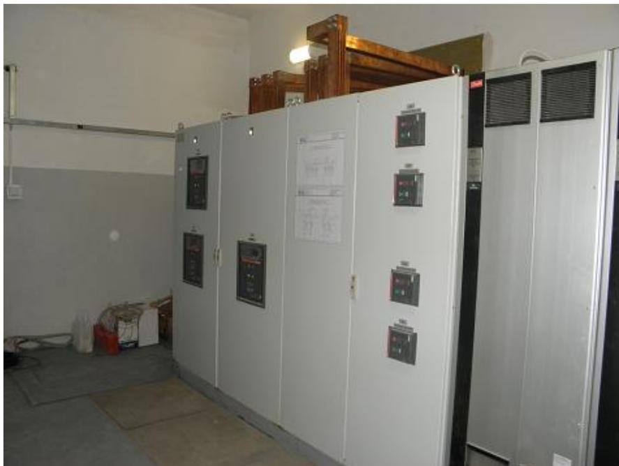
Внедрение преобразователей частоты Danfoss на ПНС №4 позволило:
