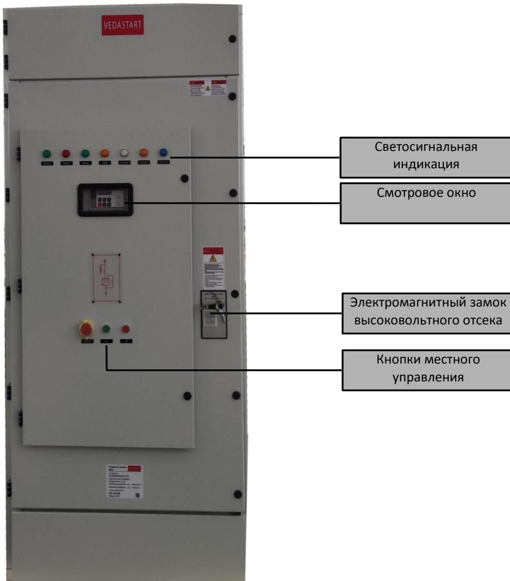
Рис. 7.3 - Внешний вид передней панели УПП Vedastart
